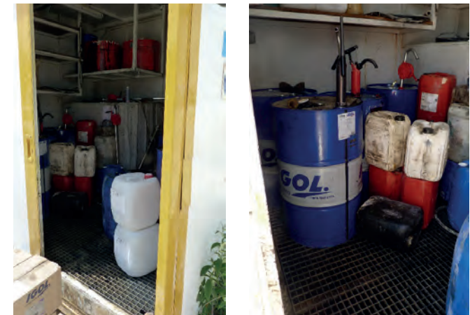
▲ Exemple de réserves d'huile sur rétention dans un container spécialisé
