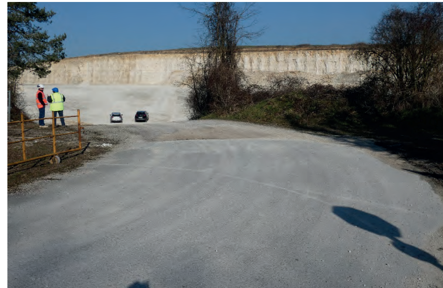
▲ La voie d'accès en matériaux enrobés
