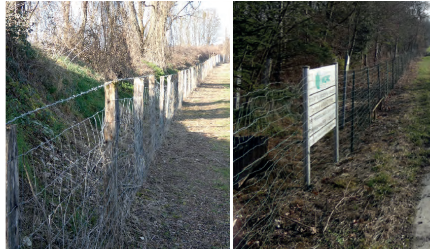
◀ La clôture en périphérie du site
