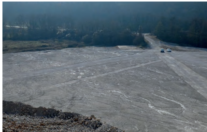
Les axes préférentiels de ruissellement sur le carreau et le point bas de collecte des eaux de ruissellement
